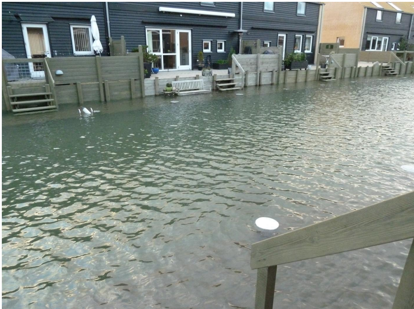
Højvande på Marcussens Bro - december 2013.
