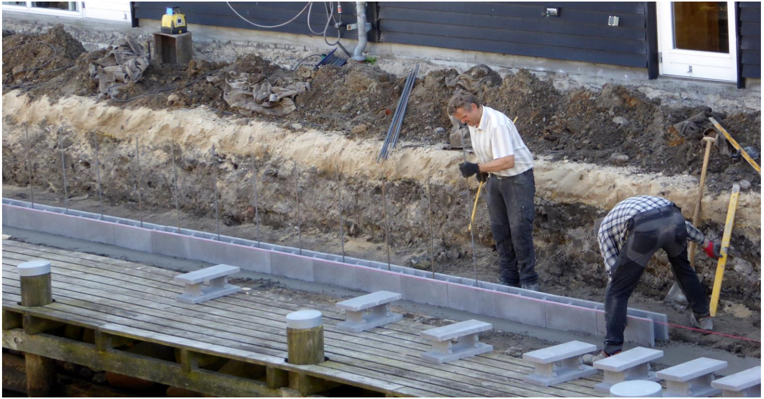
En betonmur bliver til på Marcussens Bro - efteråret 2021
