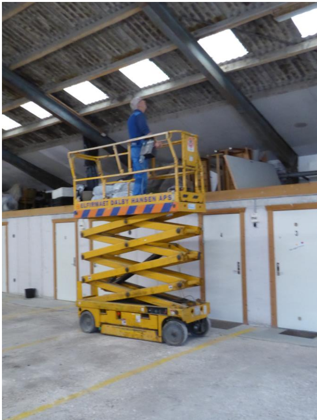
Poul i gang med at fjerne de gamle lamper
